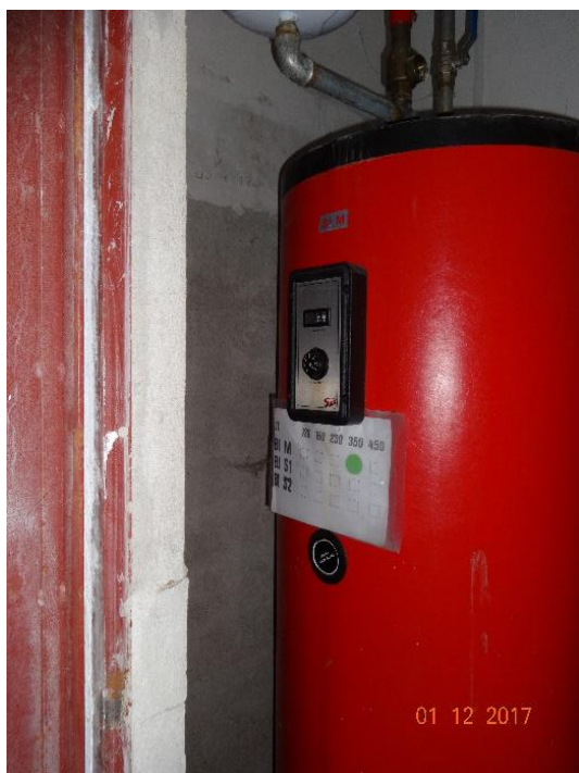
Figura 4.12 - Accumulo con serpentino di scambio termico
