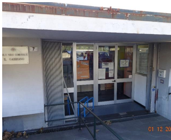
Figura 1.1 - Vista della facciata [esposta a Nord]
