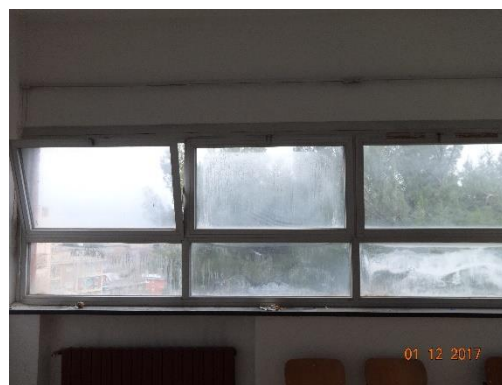
Figura 8.3 – Particolare dei serramenti esistenti
