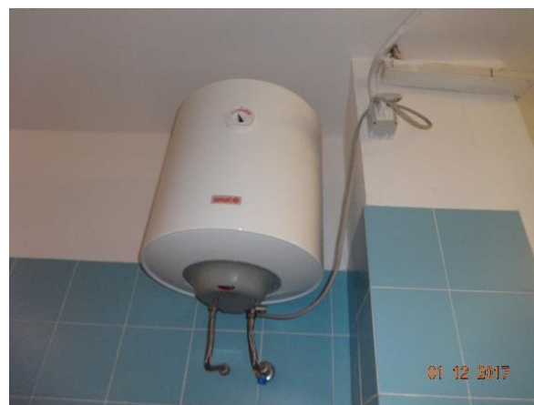
Figura 4.13 - Boiler elettrico
