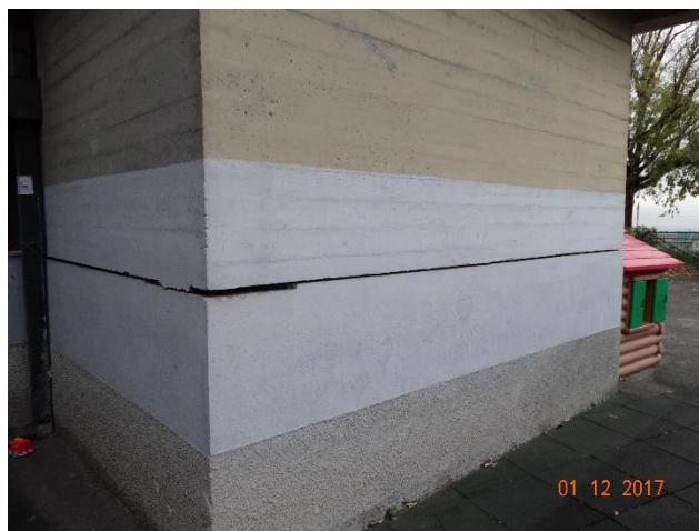
Figura 8.1 - Particolare muratura esterna
